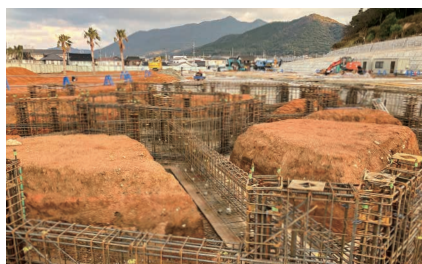
2023年12月 園芸棟の基礎工事
